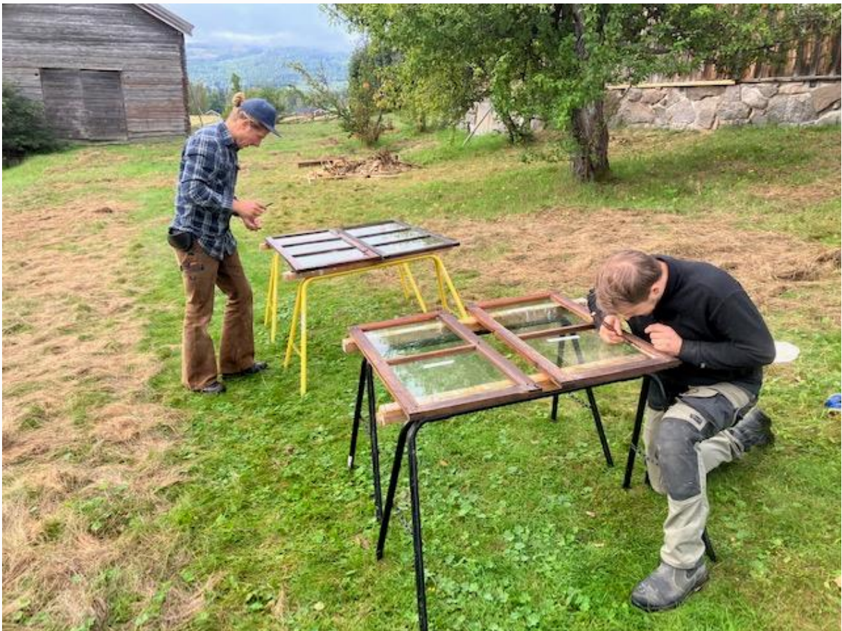
Bild från renovering hembygdsgården, ordförande Ninni Bagge.
